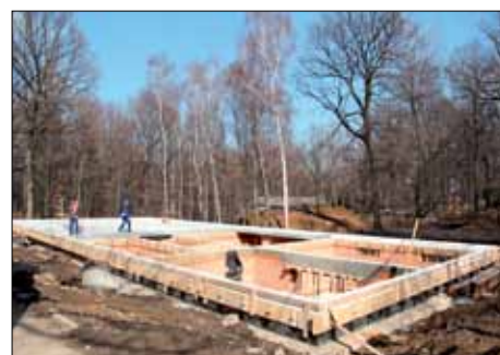
Základy nového Návštěvnického centra
